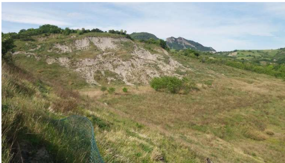
Foto 3 – panoramica del fronte cava al margine Ovest del sito, in Comune di Talamello. La foto è scattata al confine tra i due comuni. Il fronte cava, originariamente gradonato, si presenta in buona parte rinaturalizzato e con diffusa propensione al dissesto per colamento.
