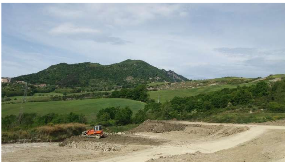
Foto 8 – interventi di colmatazione dei vuoti nella UMI in corso di sistemazione.
