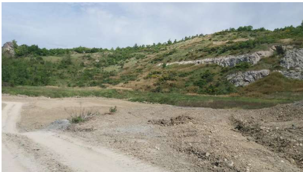
Foto 6 – UMI in corso di sistemazione, nel settore Ovest dell'ambito. Sullo sfondo il fronte già recuperato ed inerbito; in primo piano la pista di accesso e i materiali sterili conferiti per il ritombamento.
