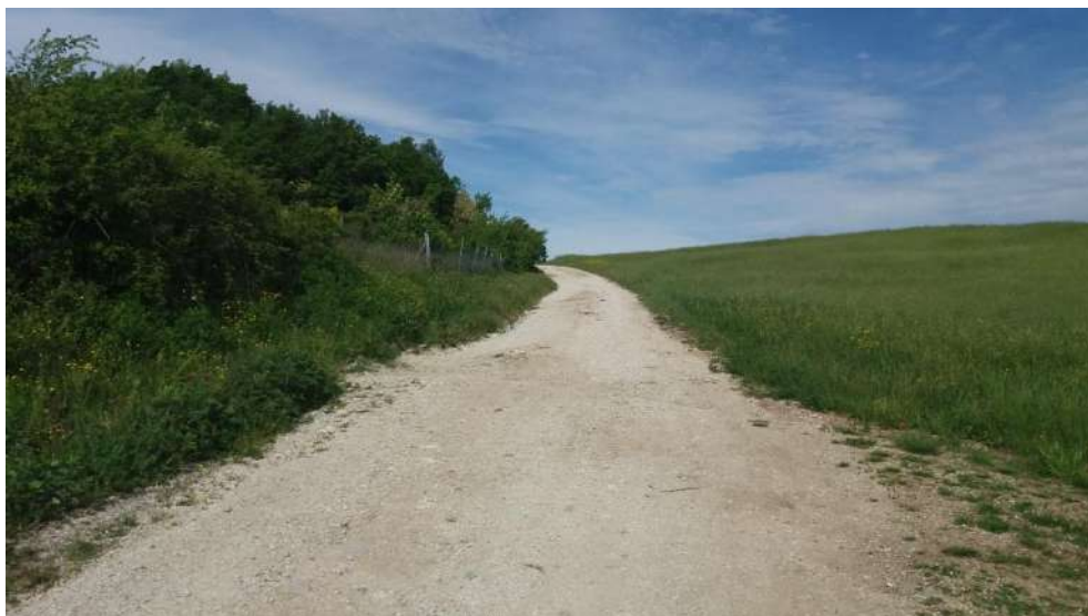
Foto 9 – strada comunale I Monti, al margine Nord dell’ambito estrattivo. Sulla sinistra nella foto la recinzione che delimita l’area estrattiva attiva.
