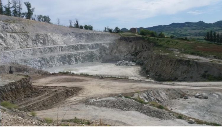
Foto 1 – panoramica dell'area nella quale è in corso l'attività estrattiva (in fase di esaurimento).
