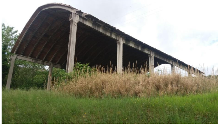
Foto 8 – tettoia in cls e laterizio retaggio della passata attività estrattiva, elemento sicuramente incongruo nel contesto locale.
