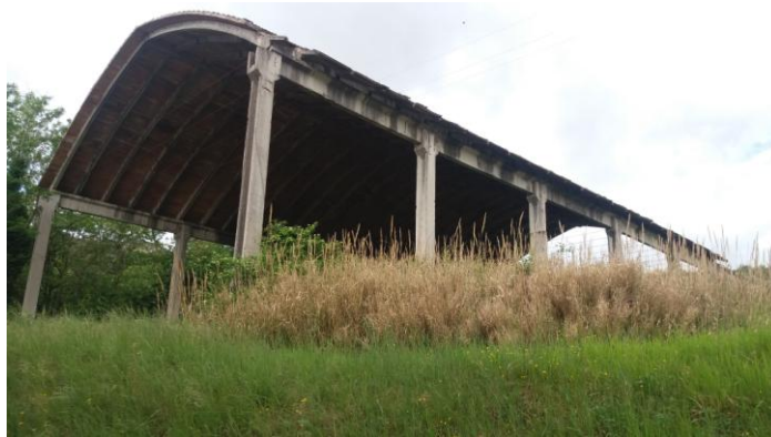
Fig. 23 – tettoia residuale nella cava dismessa ex fornace Mattei Colombo di Campiano.
