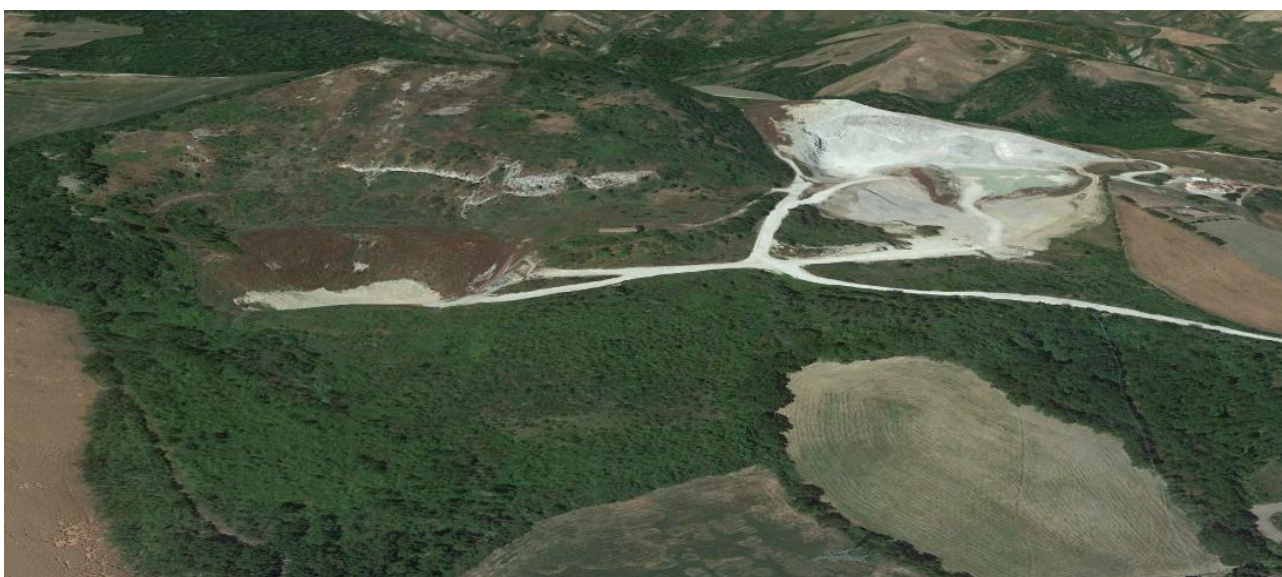
Fig. 14 - panoramica in volo 3D (RER3D Regione Emilia-Romagna) della placca calcarea del Polo SMN2; sulla sinistra la zona con attività di sistemazione morfologica in corso, sulla destra la UMI attiva e di futura estrazione.
