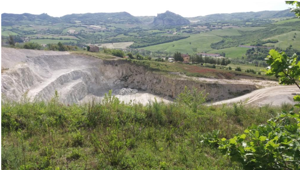
Fig. 9 – panoramica del sito di cava Case Monti; sulla sinistra il fronte cava gradonato (scavo a trincea) sui calcari della F.ne di San Marino, sullo sfondo i rilievi di San Leo e Monte S. Severino.
