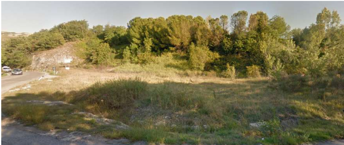
Foto 2 – fronte estrattivo attivo a fine anni settanta a ridosso della SP258 (foto del 2018). Il fronte cava si presenta rinaturalizzato.
